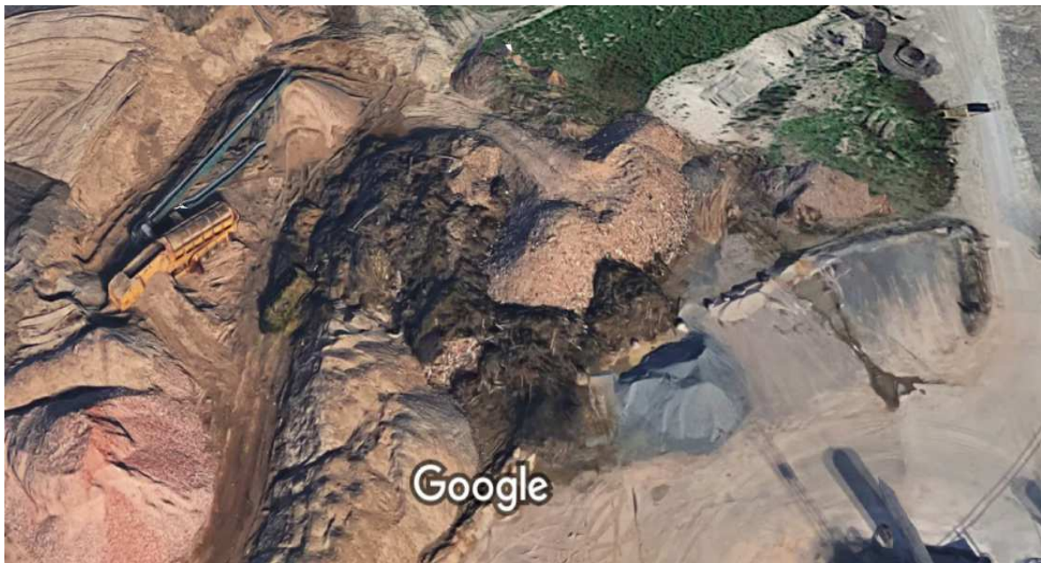
Abb.11 MAZ-Behandlungsbereich BE3030 Altholz – Schredderanlage + Ablagerung © Google2016
